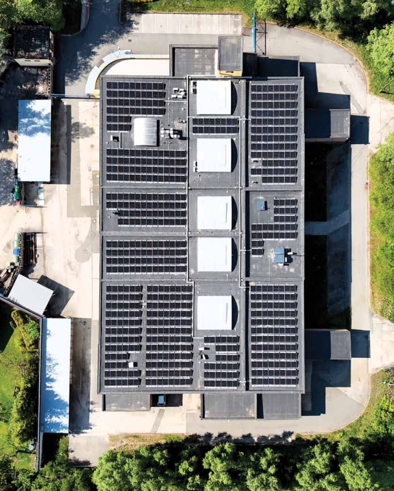
Fotovoltaická elektrárna na střeše sídla společnosti HTS
