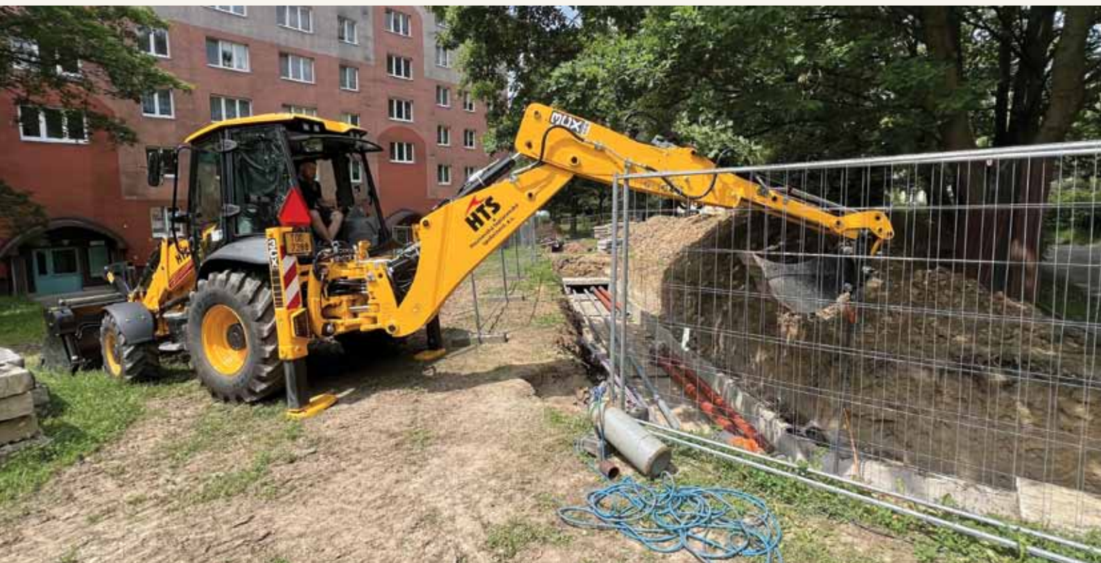
Rekonstrukce potrubí HTS na ulici E. Holuba, Havířov
